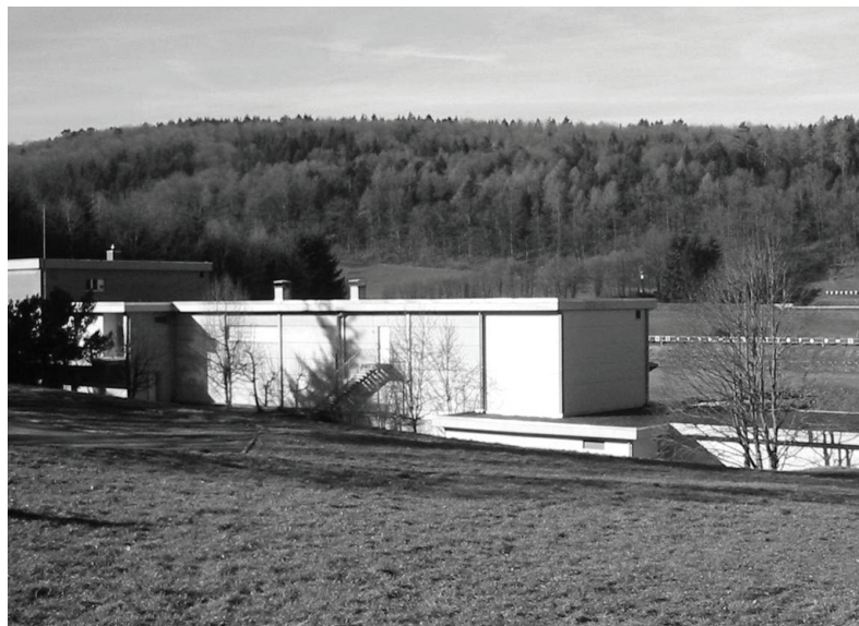
Schiessportanlage Sichert 4410 Liestal Das Schiesssportzentrum für Ihre Kurse und Anlässe
